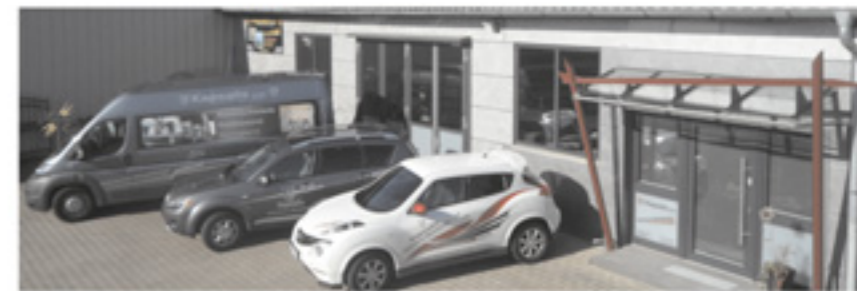
2013 wurden Fassade und Büroraum des Betriebes renoviert.
